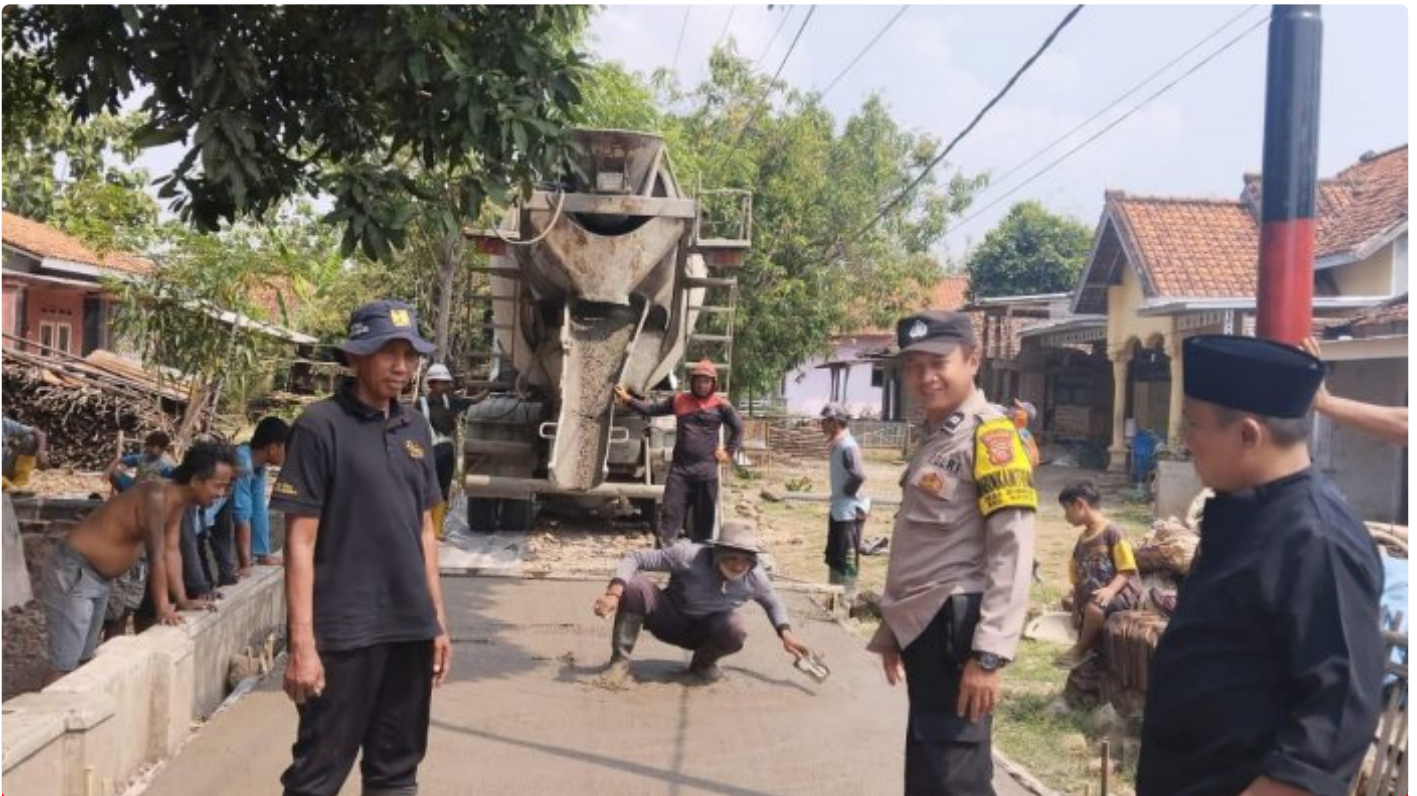
Bhabinkamtibmas Polsek Kroya Laksanakan Monitoring Pengecoran Jalan Di Desa Sumbon
